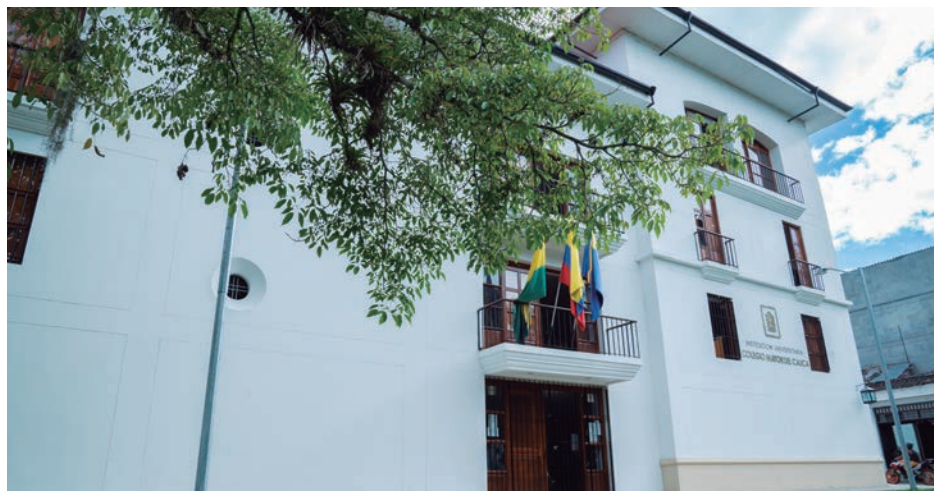
Figura 5 Sede Bicentenario (fachada principal). Fuente. Eduardo José Castro.
